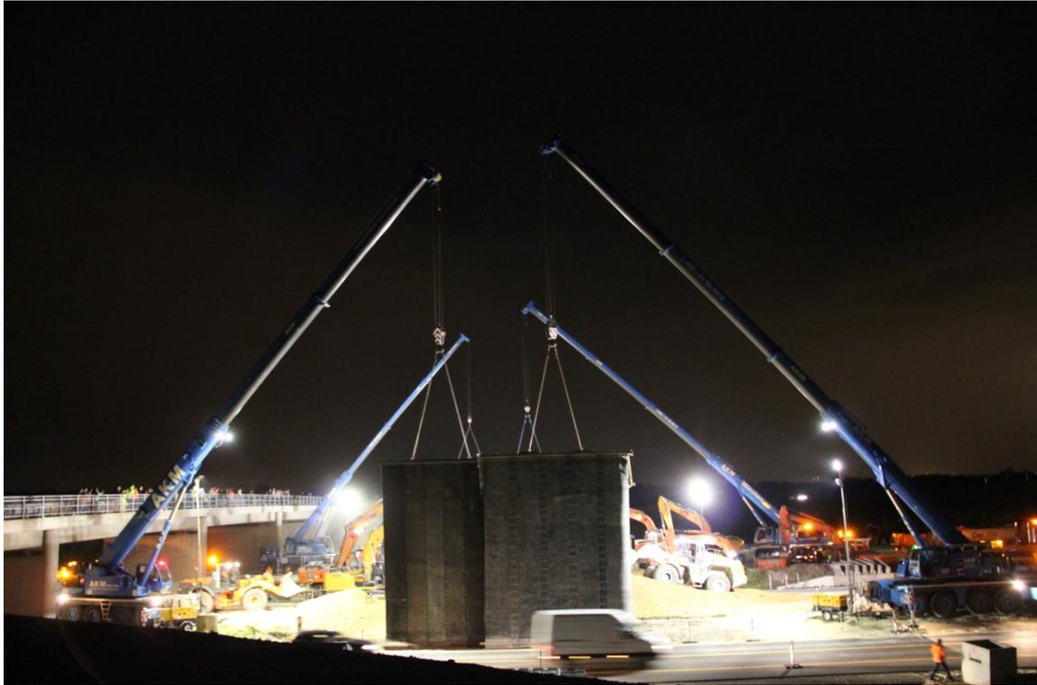
Abbruchvorhänge aus Förderbandmaterial zum Schutz des fließenden Verkehrs
