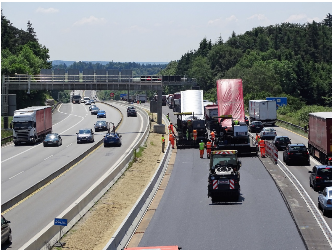
Einbau des Dünnschichtbelags DSH-V
